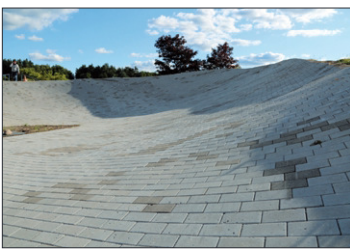
„Heißes Pflaster“, auf dem BMX-Fahrer die Kurve kriegen: Rund 900 Quadratmeter Pflastersteine haben die Vereinsmitglieder verlegt.
